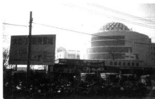
图 20 在拆除行動之後所建起的一座新的服裝交易城
